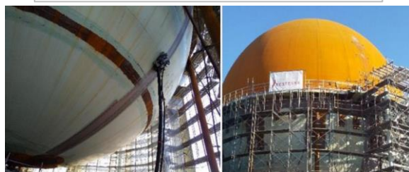
左：三谷産業のプラスト処理技術による塗膜剥離 右：ベステラによる上半球の塗膜剥離
