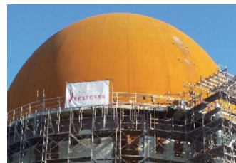
ベステラ(株)による上半球の塗膜剥離が完了
