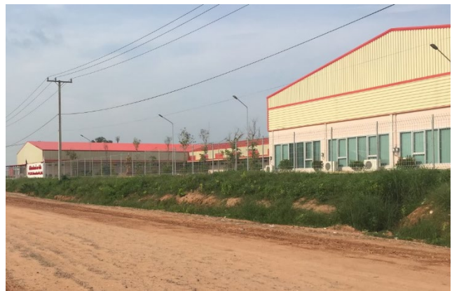
寄贈した建屋外観
