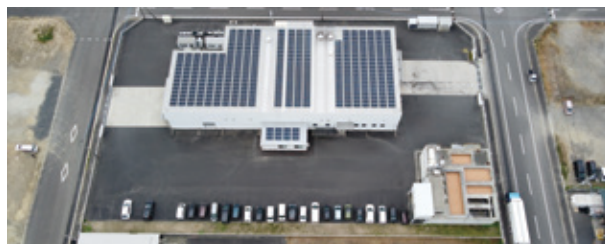
SMP阿久根工場加工センター 太陽光発電設備
