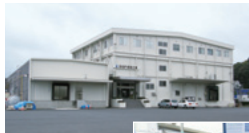
松尾工場で第二製造 ラインを増設
