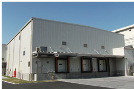
増改築した加世田工場 (2013年4月12日竣工)
