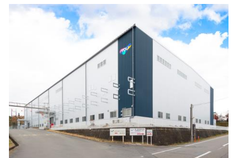
広化東リフロア新3号ライン
