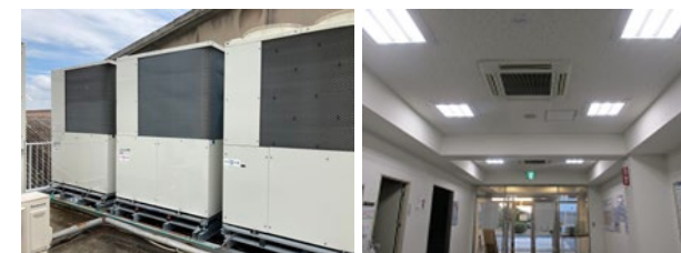
GHP更新(京都工場)
