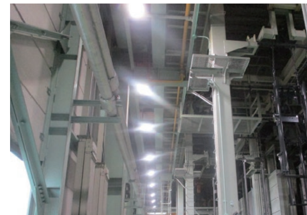
⑤ 工場の照明をLED化
