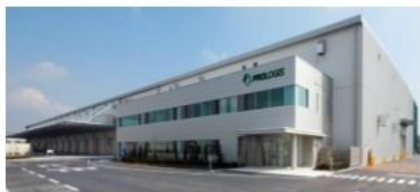
キリングgroupロジスティクス 東日本支社湘南支店 海老名物流センター外観
