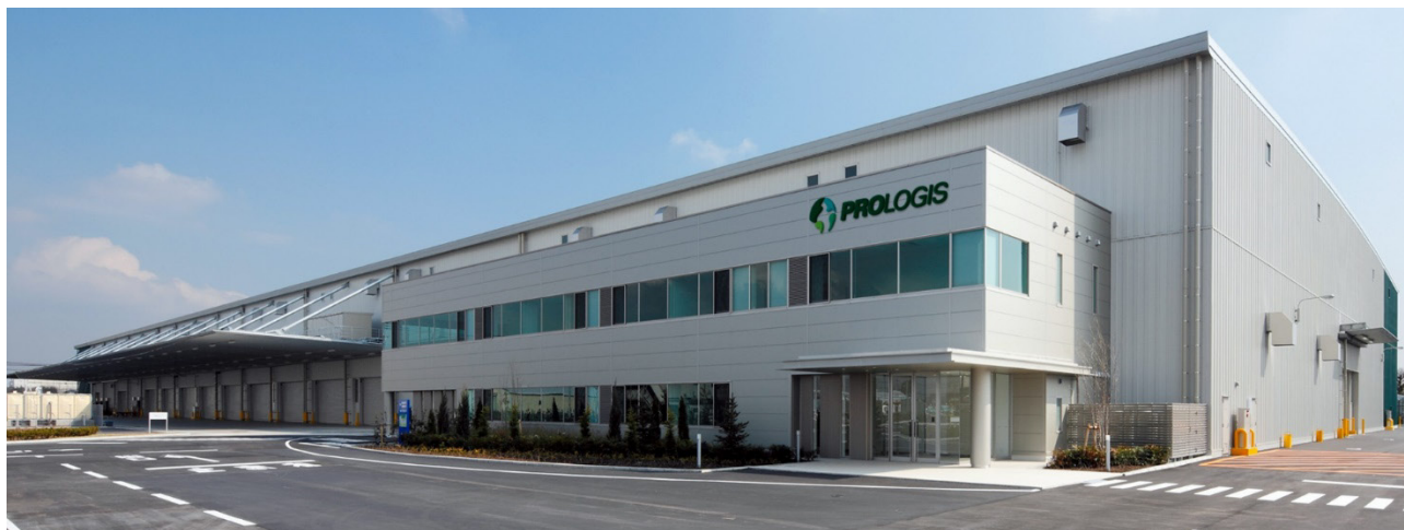
キリングgroupロジスティクス東日本支社相南支店海老名物流センター外観
