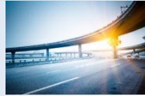
高速道路・橋梁
