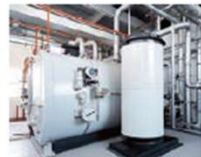
●ポンプ実験室
