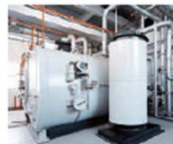
●ポンプ実験室
