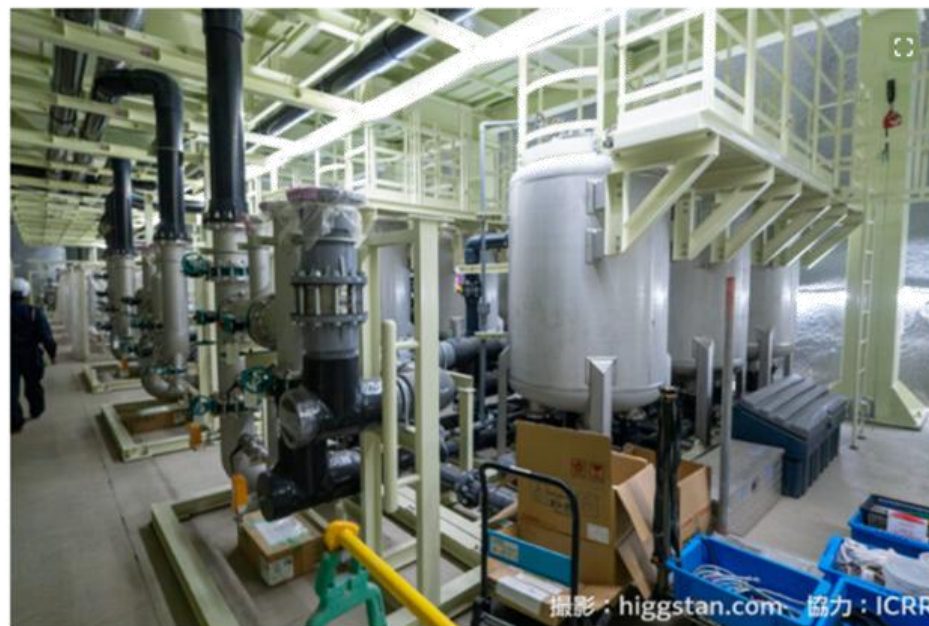
現在建設中の当社超純水製造装置
