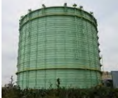
ガスホルダ 耐震性に優れたドライシール型
