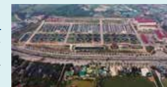
処理場全景 JFEエンジニアリング提供
