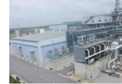
海外大型プラント （マレーシア）
