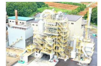
廃棄物処理設備
