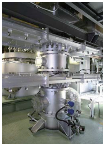
ガス化炉本体
