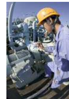
設備メンテナンス
