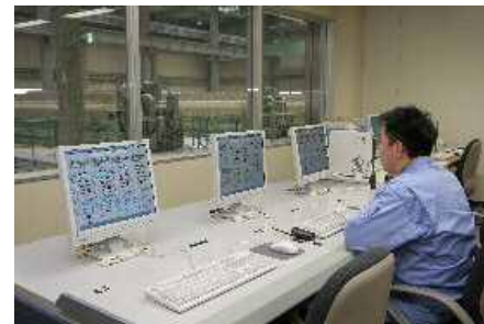
処理場オペレーター室
