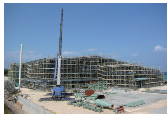
建設中の黒糖製造施設 (波照間島向け 2013年10月現在)
