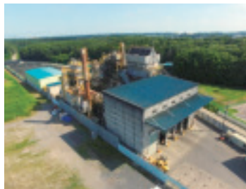
廃棄物焼却設備全景
