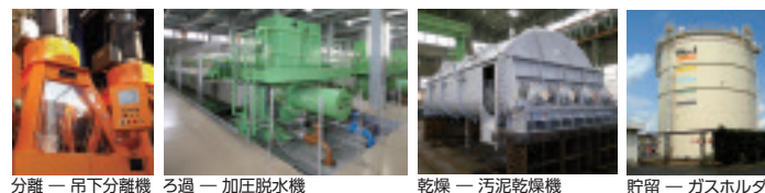
分離 — 吊下分離機 ろ過 — 加圧脱水機 乾燥 — 汚泥乾燥機 貯留 — ガスホルダ
