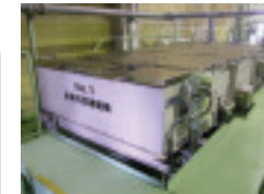
④汚泥を濃縮するベルト濃縮機
