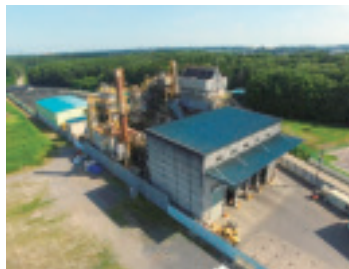
廃棄物焼却設備全景
