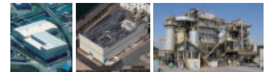
寒川浄水場排水処理PF1事業 広島市西部水資源再生センター下水汚泥燃料化DBO事業 廃棄物処理・サマル発電事業
