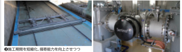
④耐塩素性原虫類、ウイルス等を無害化する「紫外線消毒装置」
