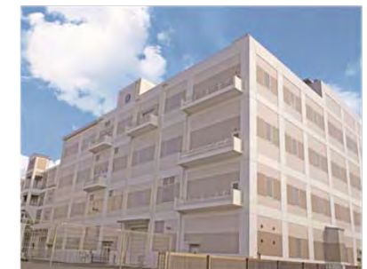
▲ 大阪市平野処理場 燃料化施設外観
