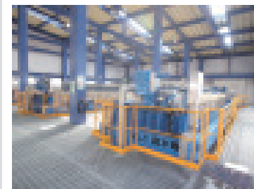
④濃縮した浄水汚泥を脱水し減容化する「加圧脱水機」
