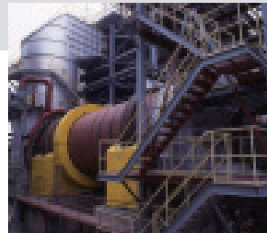
「産業廃棄物焼却設備」
