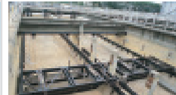
①沈殿池の泥を掻き寄せる「水没クラリファイヤ」
