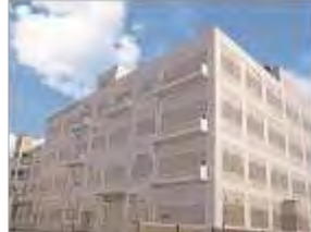
▲ 大阪市平野処理場 燃料化施設外観
