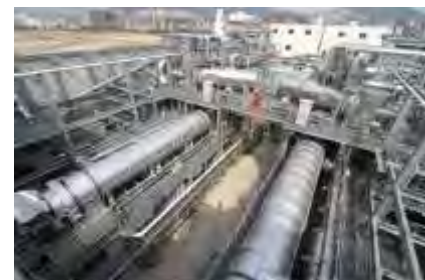
下水汚泥燃料化システム
