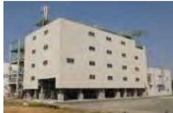
▲ 神奈川県相模川右岸処理場 焼却施設外観
