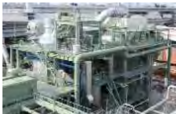
▲ 東京都葛西水再生センター 焼却施設外観
