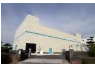
▲ 広島西部水再生センター 燃料化施設外観
