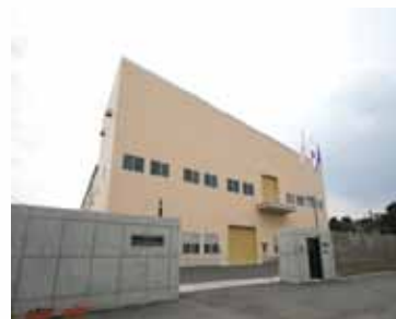
寒川ウォーターサービス外観 (日本初の上下水PFI事業)
