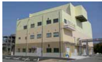
▲ 熊本市南部浄化センター 燃料化施設外観
