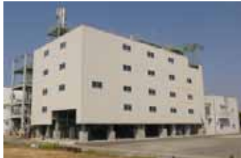
▲ 神奈川相模川右岸処理場 焼却施設外観
