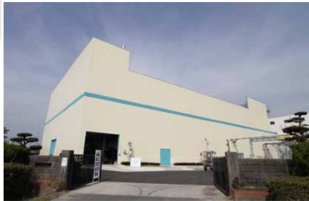
▲ 広島西部水再生センター 燃料化施設外観
