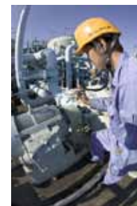
設備メンテナンス
