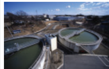
1 浄水汚泥を濃縮、減容化する「濃縮設備」
