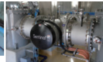
4 耐塩素性原虫類、ウイルス等を無害化する「紫外線消毒装置」
