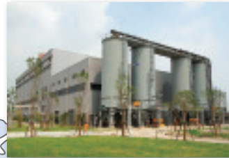
上海市向け 下水汚泥乾燥・焼却設備 (中国)
