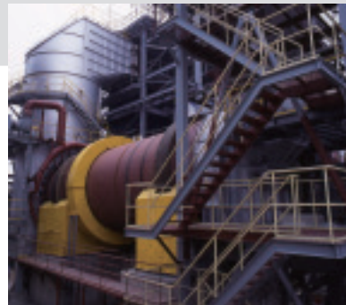
「産業廃棄物焼却設備」
