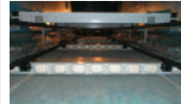
①耐震性・メンテナンス性を向上させた「浮上型チェーンプライト式掻き寄せ機」
