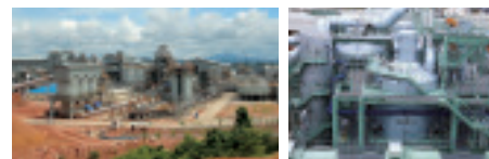
インドネシア・アルミナ製造設備の建設
