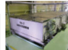
④汚泥を濃縮するベルト濃縮機
