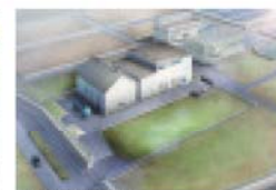
尾張西部浄水場
