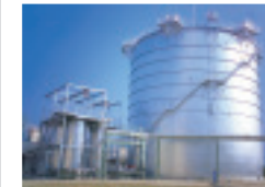
⑥ 消化ガスを貯留するガスホルダ
