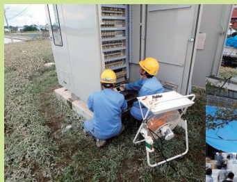
水没した下水道関連施設の点検および復旧
