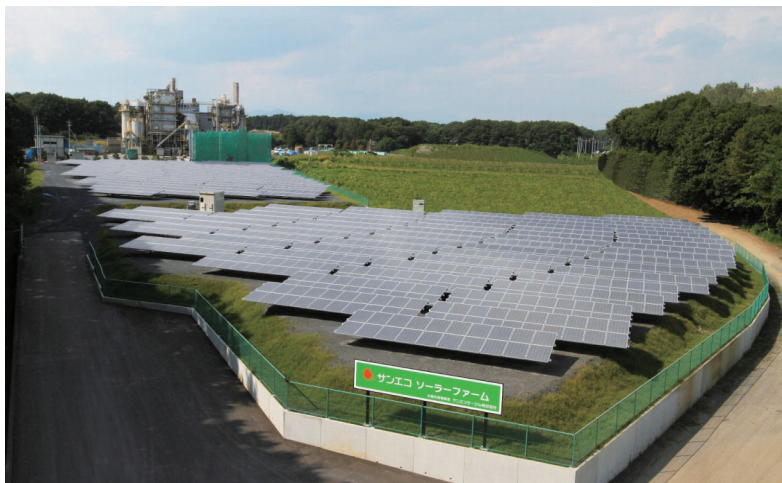
太陽光パネル設置状況
