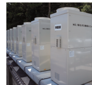
消化ガス発電設備
