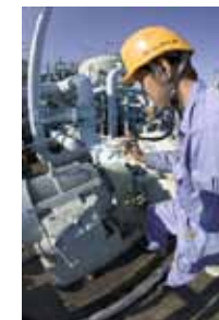
設備メンテナンス
