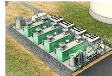
FIT消化ガス発電設備
