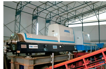
仙台市南蒲生浄化センター向け仮設汚泥脱水設備を設置
