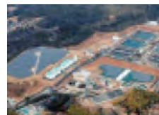
浄水場排水処理PFI事業
