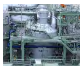
次世代型 汚泥焼却
