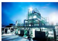
下水汚泥 脱水乾燥
