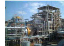
固形廃棄物処理設備
