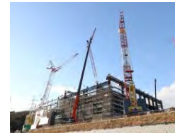
ごみ焼却炉 プラント工事
