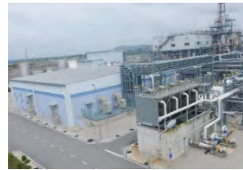
海外大型プラント (マレーシア)
