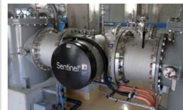
②耐塩素性細菌、ウイルス等を無害化する「紫外線滅菌装置」
