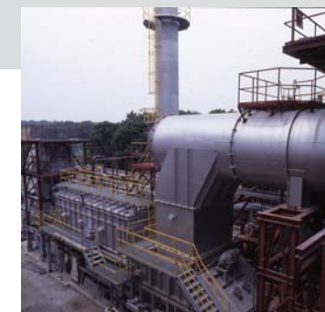
「一般廃棄物焼却設備」
