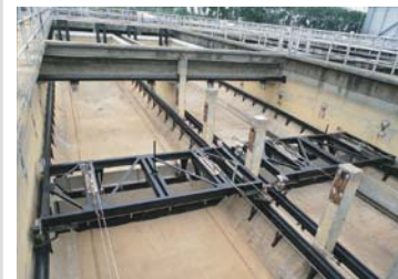
①沈殿池の排泥を掻き寄せる「水没クラリファイヤ」
