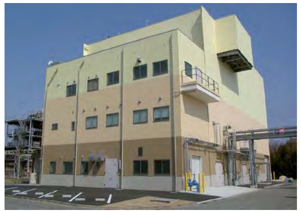
▲ 熊本市南部浄化センター 燃料化施設外観
