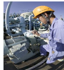
設備メンテナンス
