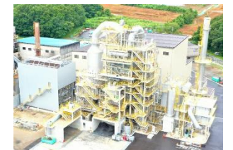
廃棄物処理設備
