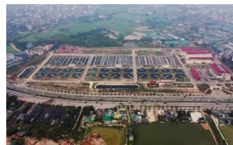
処理場全景 (JFEエンジニアリング(株)提供)
