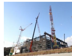
ごみ焼却炉 プラント工事
