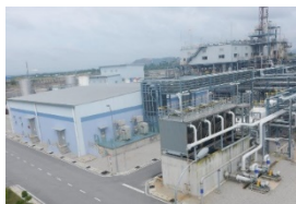
海外大型プラント (マレーシア)
