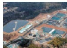
浄水場排水処理PFI事業
