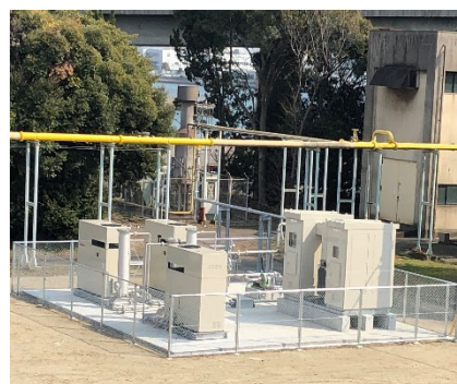
新南陽浄化センター消化ガス発電設備
