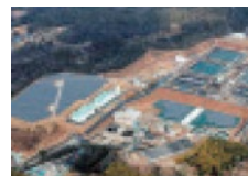
浄水場排水処理PFI事業
