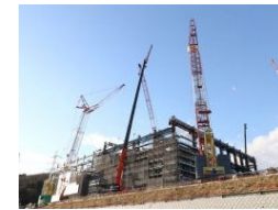
ごみ焼却炉 プラント工事
