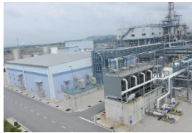
海外大型プラント (マレーシア)
