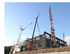
ごみ焼却炉 プラント工事
