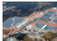
浄水場排水処理PFI事業
