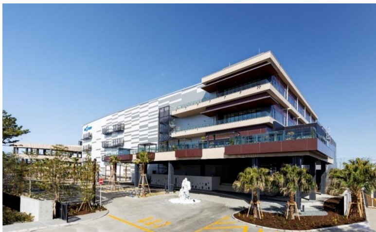
物流施設外観
