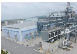
海外大型プラント (マレーシア)
