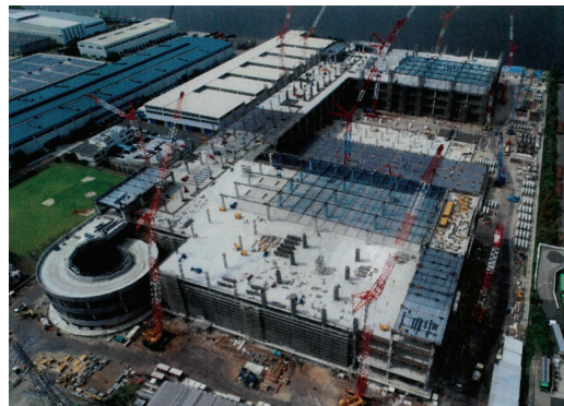
建設工事の状況
