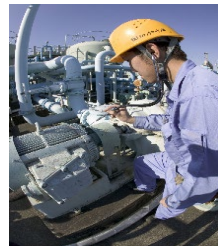
設備メンテナンス
