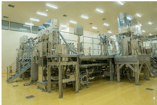
真空乳化機設備(全体)
