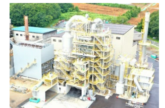
廃棄物処理設備
