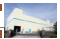
広島市西部水資源再生センター
