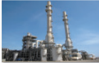
廃液燃焼設備 (サウジアラビア)
