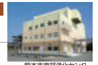
熊本市南部浄化センター
