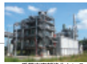
千葉市南部浄化センター
