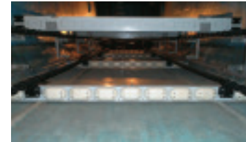
①耐震性・メンテナンス性を向上させた「浮上型チェーンブライド式掻き寄せ機」
