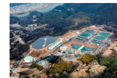
愛知県内2浄水場 排水処理PFI事業
