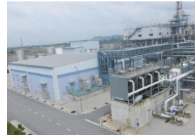
海外大型プラント (マレーシア)
