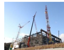
ごみ焼却炉プラント工事
