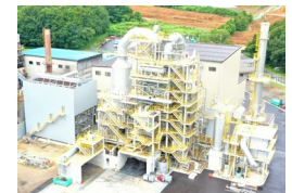
廃棄物処理設備
