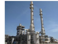
廃液燃焼 システム
