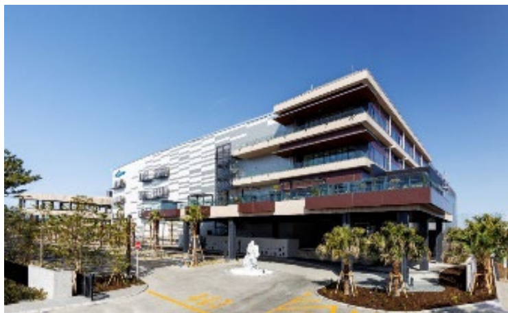
物流施設 (千葉県市川市)
