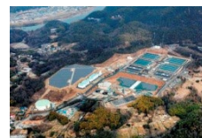
愛知県内2浄水場 排水処理PFI事業
