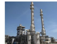
廃液燃焼 システム
