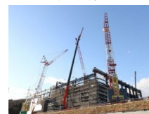
ごみ焼却炉プラント工事
