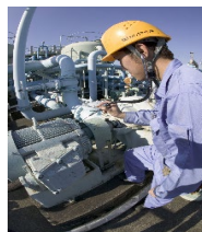
設備メンテナンス
